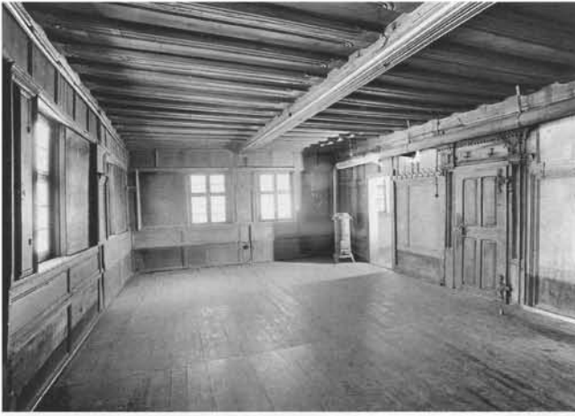
„Ratssaal“ nach Südosten. Die spätgotische Bohlenbalkendecke überspannt den gesamten Raum, der im frühen 18. Jahrhundert eine neue Wandvertäfelung inklusive Fensterverschlüsse erhielt. Der Eisenofen stammt aus dem späten 19. Jahrhundert Foto: E. Lantz
