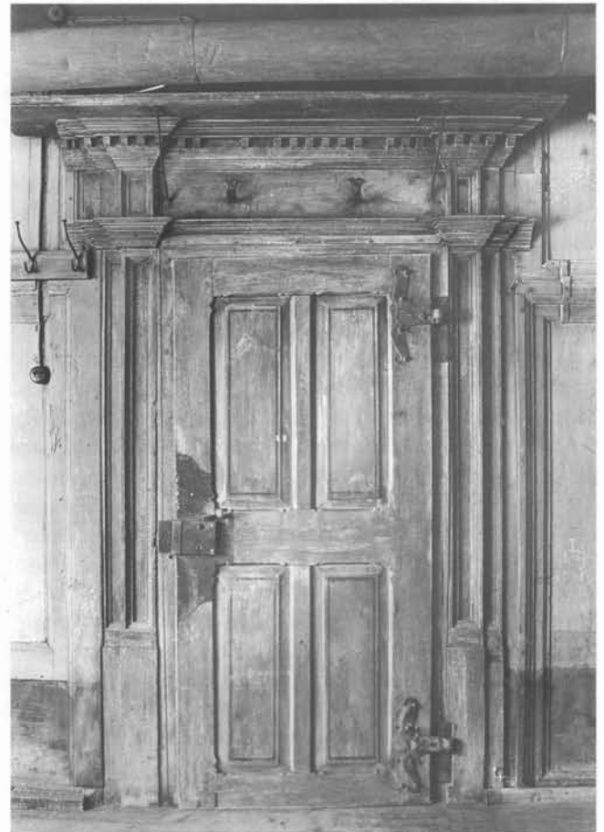
Türblatt und Türstock des frühen 18. Jahrhunderts mit originale Beschlagwerk Foto: E. Lantz
